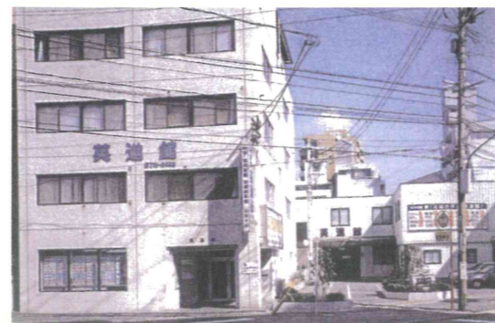
手前は昭和59年に完成した自社ビル第1号、奥はその3年後に完成の中学部校舎
